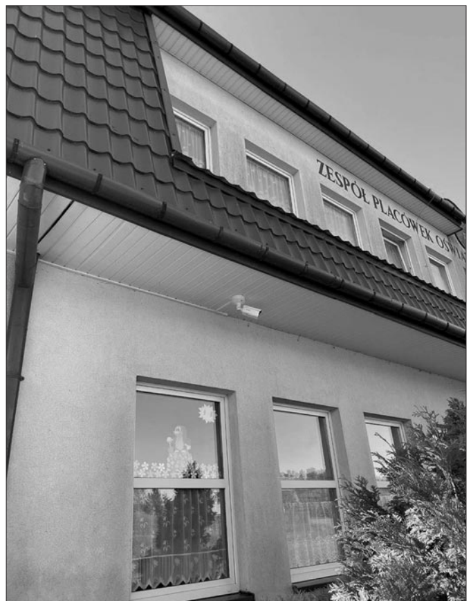
Kamera zewnętrzna – element systemu monitoringu w Szkole w Kasinie Wielkiej
