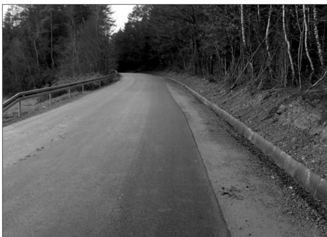
Wyremontowana droga w Kasinie Wielkiej – Ługowina
