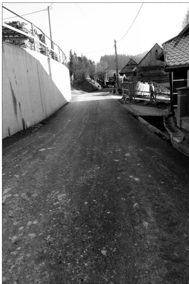
Zmodernizowana droga na os. Żury w Olszówce
