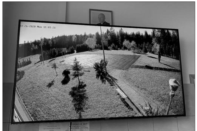
Element systemu monitoringu w Szkole w Kasinie Wielkiej
