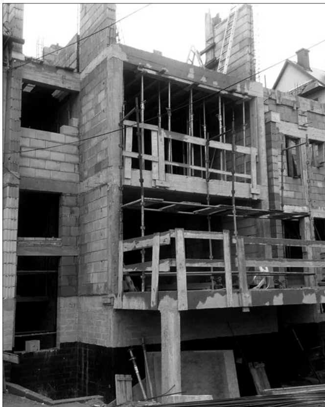
Budowa środowiskowego domu samopomocy w Mszanie Górnej
