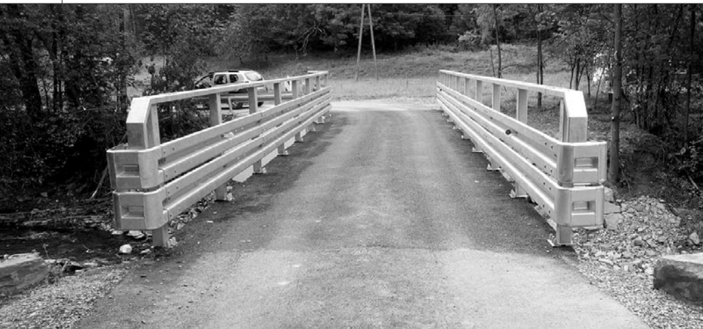
Zmodernizowany most w Mszanie Górnej na osiedlu Dawce
